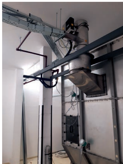
Őrölt kávé behordása tároló silóba (2. kép)
